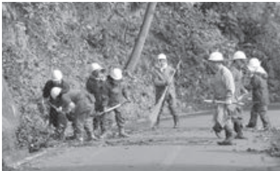
村道川代・大畑線 側溝掃除
