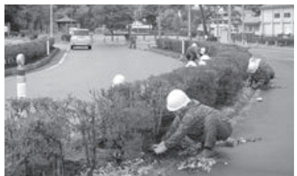
村道金ヶ沢坂ノ下線 草取り
