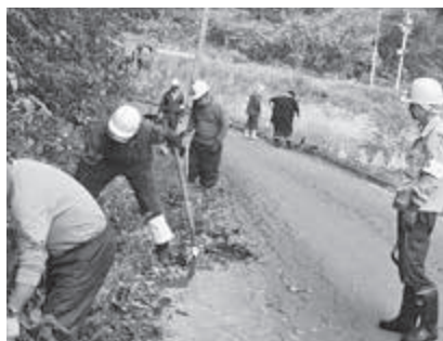
西越～松屋敷線側溝の土砂撤去
