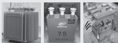
変圧器 電力用コンデンサー 開閉器
