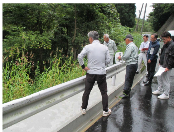
長漕・長崎線道路の復旧現場
