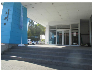
山村開発センター側の美郷館入口（階段のみでスロープが設置されていない。）
